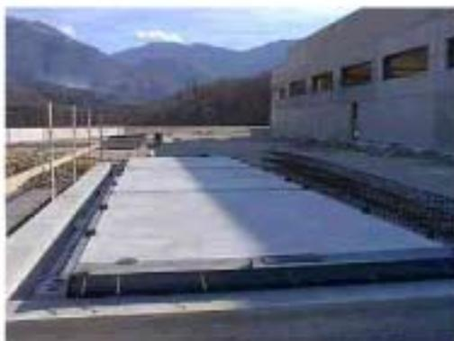
Il sistema costruttivo consente di ottenere una stadera a ponte modulare per uso stradale completamente in **cemento**. È costruita in versione compatta, in modo che l'altezza dell'impianto sia contenuta in circa cm 40. L'impianto può quindi essere installato in una buca di circa 50 cm, o fuori terra. In tal caso al piano di carico si accenderà a mezzo rampe di modesta pendenza.
